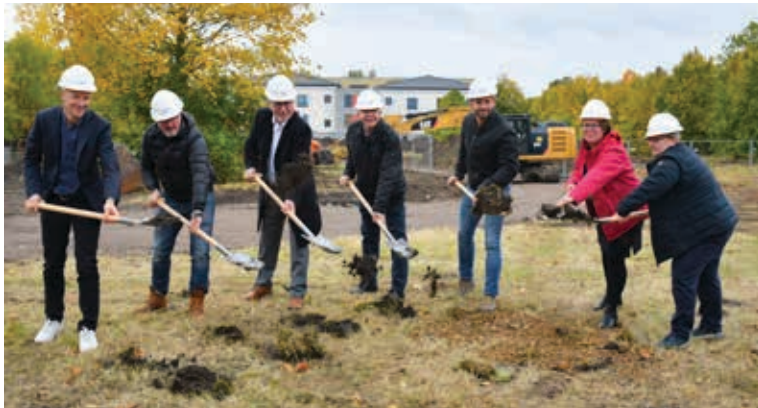
v. l.: Axel Knabe (Architekt), Mario Schollmeyer (Wagner Tiefbau), Bürgermeister Ralf Hauboldt, Christian Lohmann (Awo-Präsidium), Matthias Sack (Geschäftsführer Ersabau Sömmerda, Diana Wächter (Awo-Geschäftsbereichsmanagement), Kerstin Herrmann (Bauleiterin Awo-Regionalverband)
